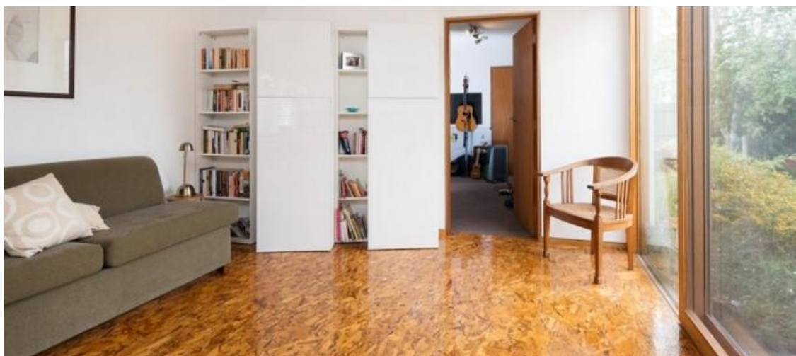
Obr. 48: Podlaha z OSB, ilustrativní příklad. Zdroj: Podlaha z OSB desek: Výběr a montáž Zdroj: http://www.drevostavitel.cz/clanek/podlaha-z-osb-desek . Dřevostavitel [online]. [cit. 2016-01-06]. Dostupné z: http://www.drevostavitel.cz/clanek/podlaha-z-osb-desek
