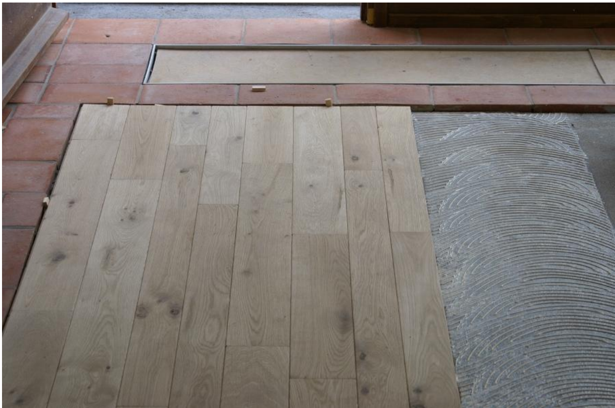
Obr. 44: Lepená masivní dřevěná podlaha, ilustrativní příklad. Zdroj: Pokládka a montáž. Dřevěné podlahy [online]. TM COMPLEX s.r.o. [cit. 2016-02-26]. Dostupné z: http://drevene-podlahy.org/pokladka-a-montaz
